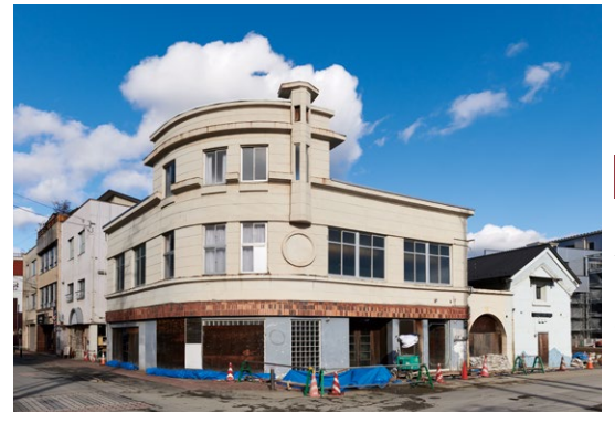
Cida House 千田家住宅 (再建中)
