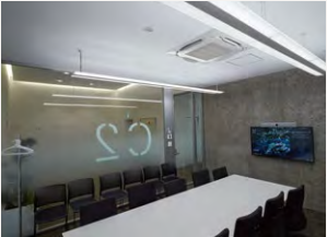
導光板照明が用いられた会議室
