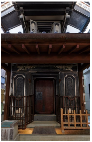
Onoken Store Storehouse 小野健商店土蔵
