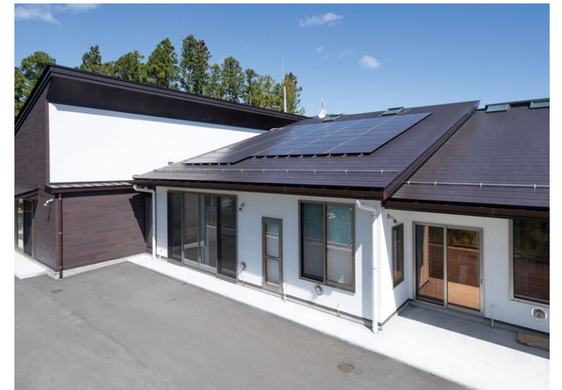
公民館の屋根に設けられた太陽電池モジュールHIT240(10kW)
