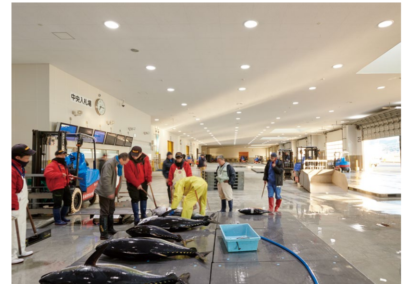
1階「荷捌場」を隅々まで照らすLEDダウンライト。明るく、自然な見え方になったとの評価。屋外対応のデジタルサイネージに入札結果が表示される
