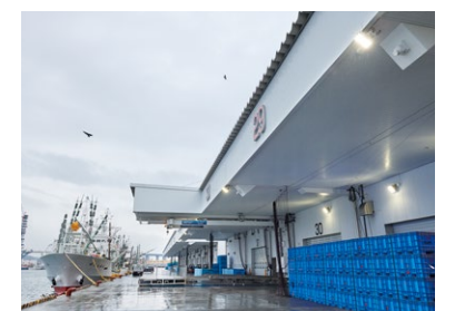
岸壁での水揚げ作業を照らすLED投光器
