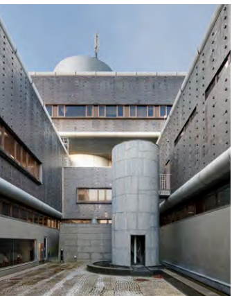
本館の円筒(写真上)にエレベータなどを集約、各階を最短距離で結ぶ。手前は非常階段。
