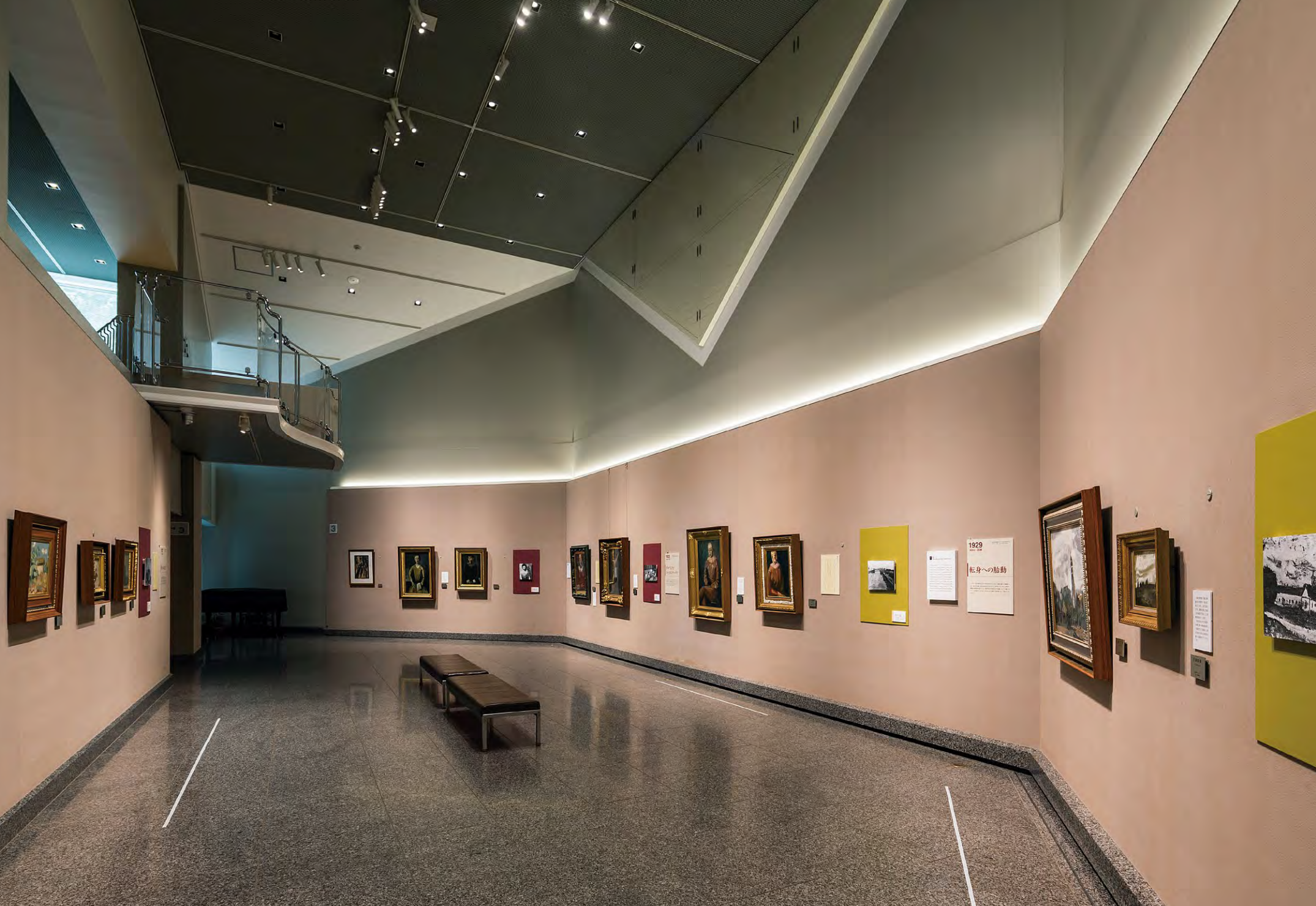
2層吹き抜けの展示室では高天井のLEDシステムライトと高演色調光スポットライトにリニューアル。展示壁面トップの間接照明が彩りを添えている
