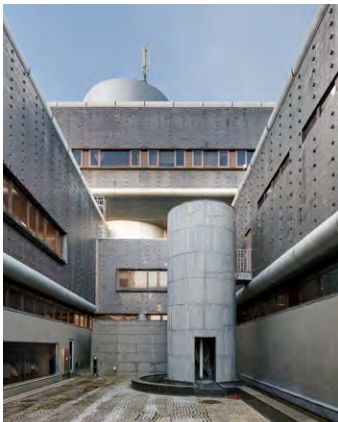
本館の円筒(写真上)にエレベータなどを集約、各階を最短距離で結ぶ。手前は非常階段。
