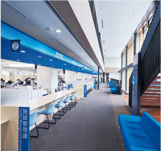
外光が差し込む2・3階吹抜では、昼光センサによりダウンライトを調光することで省エネが図られている
