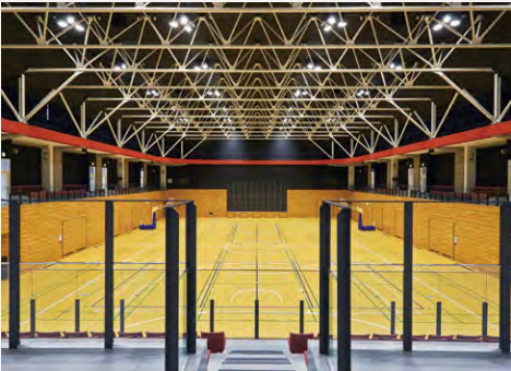
天井トラス間に3灯用バンクライトが設置されたアリーナコート
