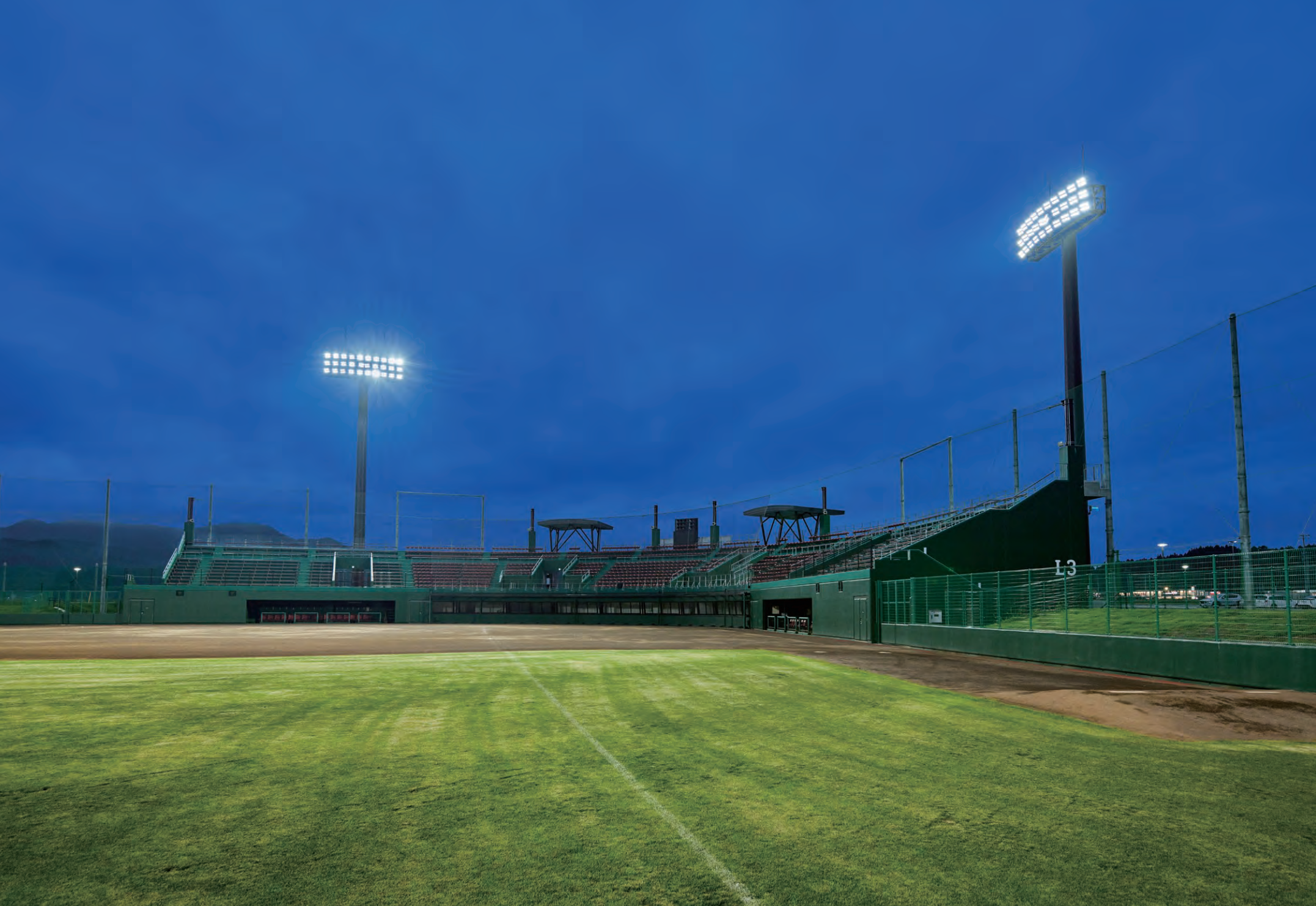
第一野球場のLED投光器は硬式野球・一般競技で内野750 lx、外野500 lx。硬式野球・レクリエーションで内野500 lx、外野300 lxなど3段階に照度レベルが切り替え可能
