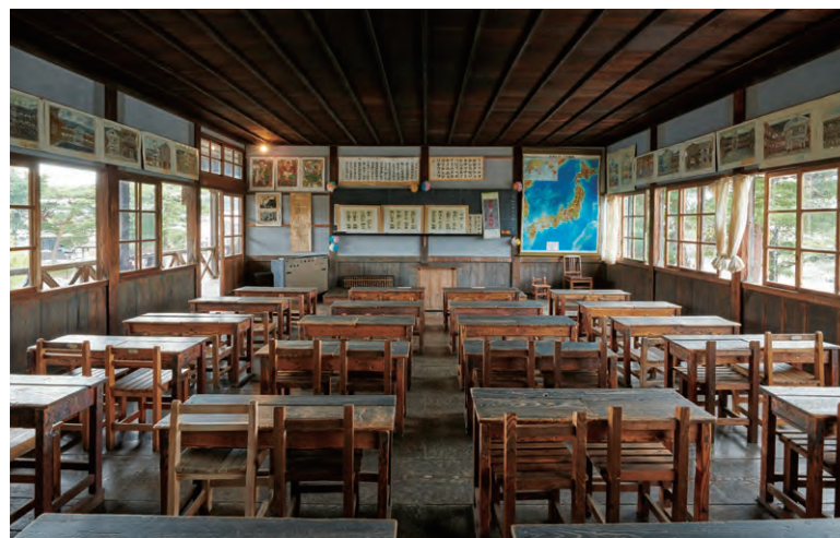
当初、教室には照明がなかったが、片廊下式の採用で教室の両側に窓が作られ、日光が十分に入った。一方、まぶし過ぎないように漆喰壁を白色ではなくぬすみ色にして児童の目を守る工夫もしている。
