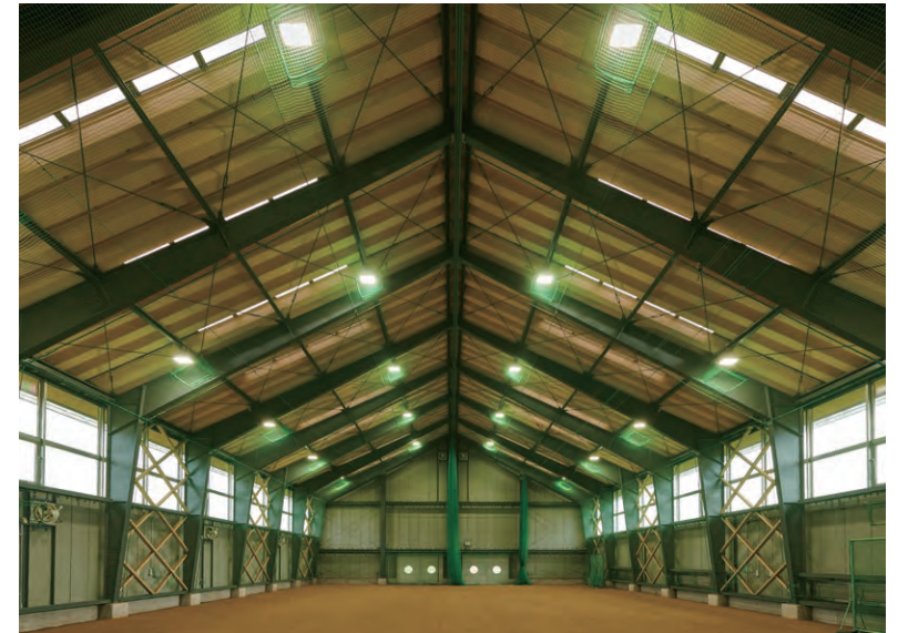
高天井用照明器具に加え、舞い上がる砂塵を排出する換気設備も備えた屋内練習場
