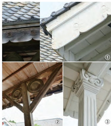
①鼻隠し板の装飾 ②学間にゆかりのあるふくろうを表したとされる腕木 ③イオニア式柱頭
