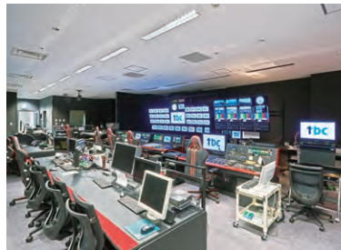
テレビ第1副調整室に設置された 映り込みを防ぐルーバ付き照明器具
