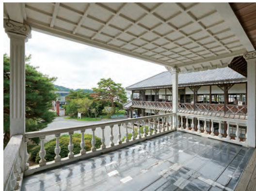
切妻屋根、格天井という和風の造りに西洋風の欄干・柱を組み合わせたバルコニー。床には腐食防止のため亜鉛板が敷かれている。
