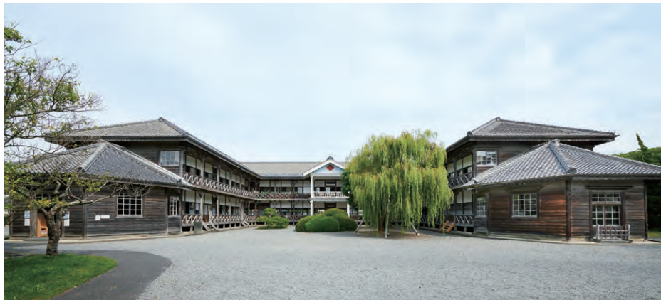
明治初期の擬洋風建築に比べ西洋風装飾は控えめとなり、廊下の配置なども変化した。校庭を囲むコの字型の校舎は、先生が児童に手を広げる形ともいわれる。吟味した素材と大工の技による堅牢な造りで水害や地震に耐え、今日に至っている。
