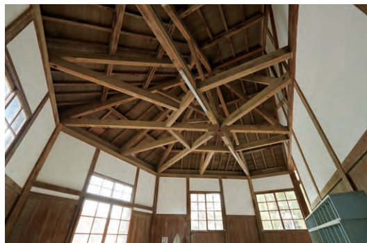
六方(昇降口)。技術力を誇った大工達でさえ苦労したという西洋風のトラス構造を現しにしている。強度に優れた蟻(あり)組の組手が見られる。
