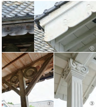
①鼻隠し板の装飾 ②学間にゆかりのあるふくろうを表したとされる腕木 ③イオニア式柱頭
