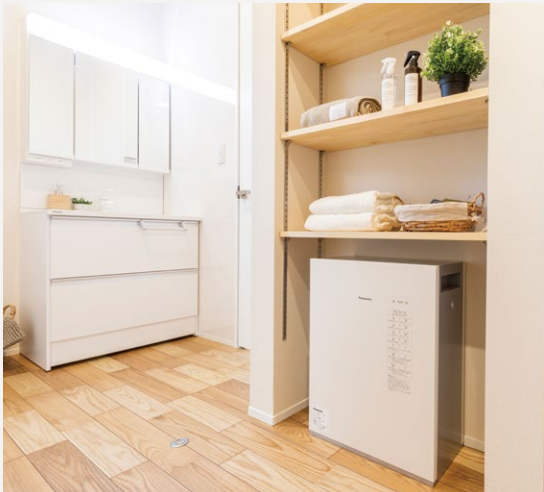
クローゼット横に5.6kWhのリチウムイオン蓄電池。 左に洗面ドレッシング「シーライン」
