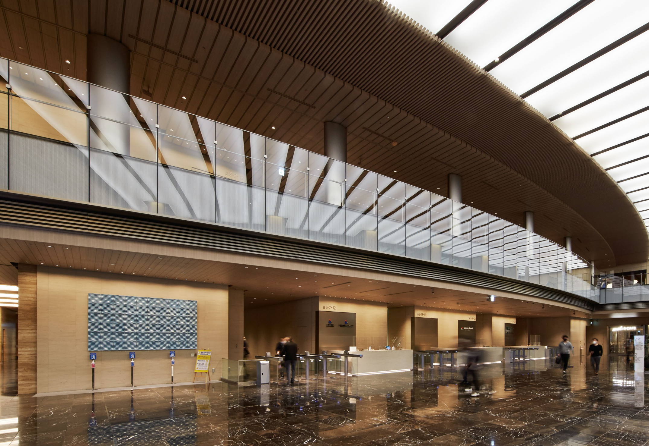
5階エレベーターホールのセキュリティゲート上に顔認証の精度を上げるために設けられたグレアレスユニバーサルダウンライトと、鉛直面照度を高める小口径ウォールウォッシャーを配置
