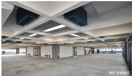
日本の意匠を表す小梁は、屋内でも構造体であり自由な間取りを実現する機能も持つ。県庁の組織変更に対応する設計思想。
