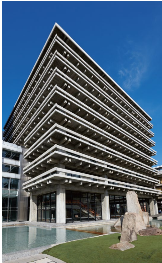
木造建築を思わせる小梁や手すりをコンクリートで表現した高層棟。等間隔に並ぶ厚さわずか114mmの小梁と、手すりのラインが目を引き。
