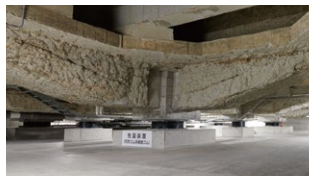
2019年、建物と地盤の間に免震装置を設置するなどの耐震改修工事が行われた。
