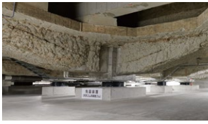
2019年、建物と地盤の間に免震装置を設置するなどの耐震改修工事が行われた。
