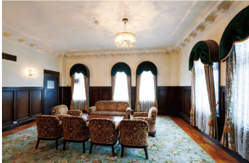
昭和天皇が訪問時に使用した3階特別室。白漆喰の天井は花座、壁との取り合い部分は渦巻き模様の持ち送りで装飾されている。左官技術が光る。
