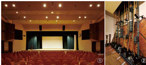
①集会場の座席は当初1,524席もあった(現在は601席)。②手動のつり物機構(綱元)。舞台上使う照明などをつり下げたバトンで綱を上げ下げする。
