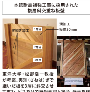
本館耐震補強工事に採用された複層斜交重ね板壁
