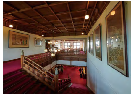
真壁造の1階に対し、2階は柱を見せない大壁造。回廊を巡って展示された数々の名画が鑑賞できる。
