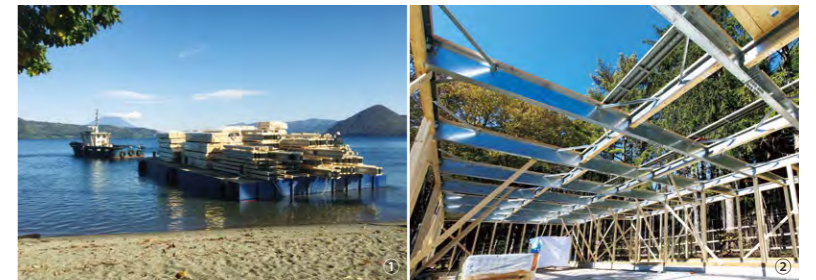
①船で運ばれたテクノストラクチャー建材 ②展示室で幅8mの柱間を実現した木と鉄の複合梁「テクノビーム」
