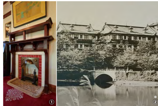
①鳥居型の飾り付きマントルピース。大正初期まで石炭を焚いてロビーや客室で使用した。②当時は数室分の煙・熱を集約し煙突から排気していた。
