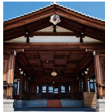
車寄せの柱梁はヒノキ、格天井は杉材。柱に打たれた釘隠しの乳唄(ちちばい)は寺院建築で見られる飾り。
