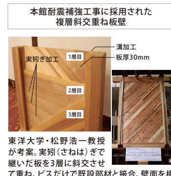
本館耐震補強工事に採用された 複層斜交重ね板壁
